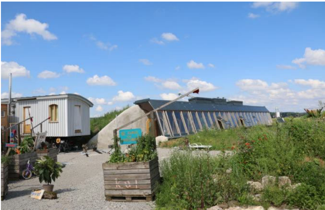
Fertiges, genutztes Earthship, Schloss Tempelhof - Quelle: Foto Jens Plackner, 24.06.2016
