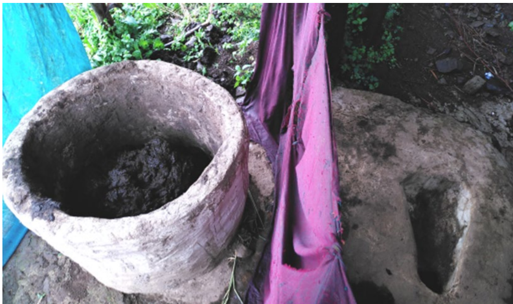
Abbildung 18 Zulauf der Biogasanlage: Mischer links und Toilette rechts (Quelle: Eigenes Foto)
