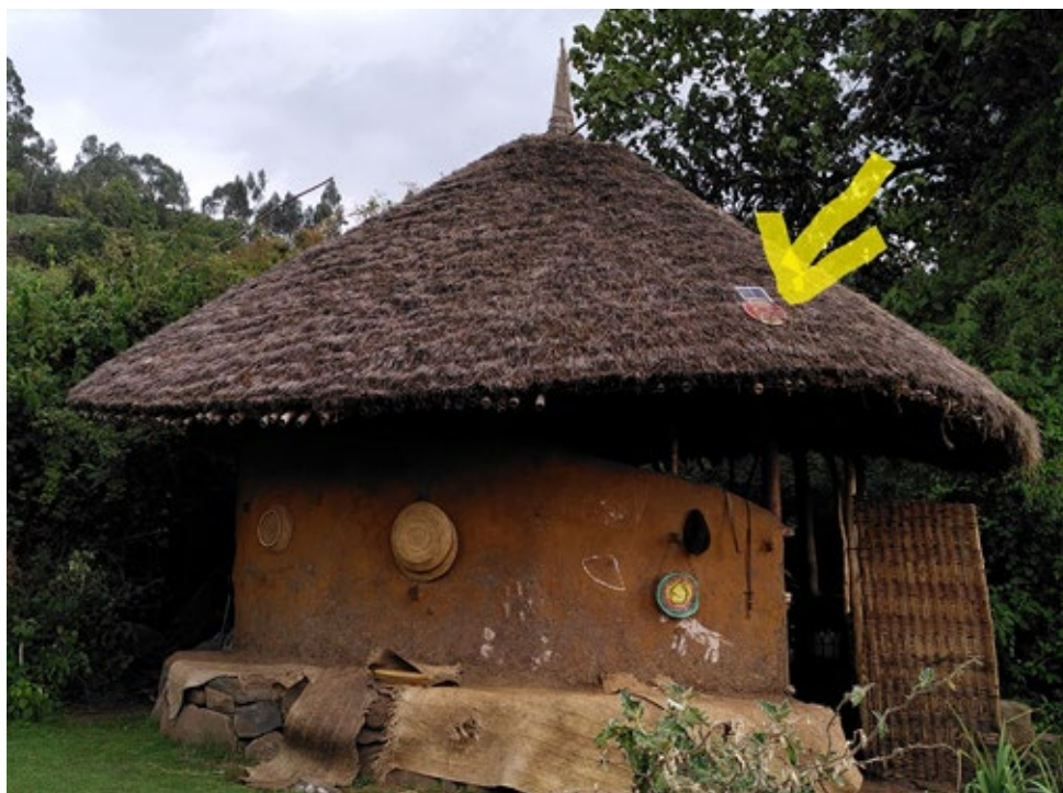
Abbildung 10 Ein 5 Watt Paneel eines SHLS von ovBeacon installiert auf einem traditionellen Rundhaus der Mulu Eco Lodge (Quelle: Eigenes Foto)
