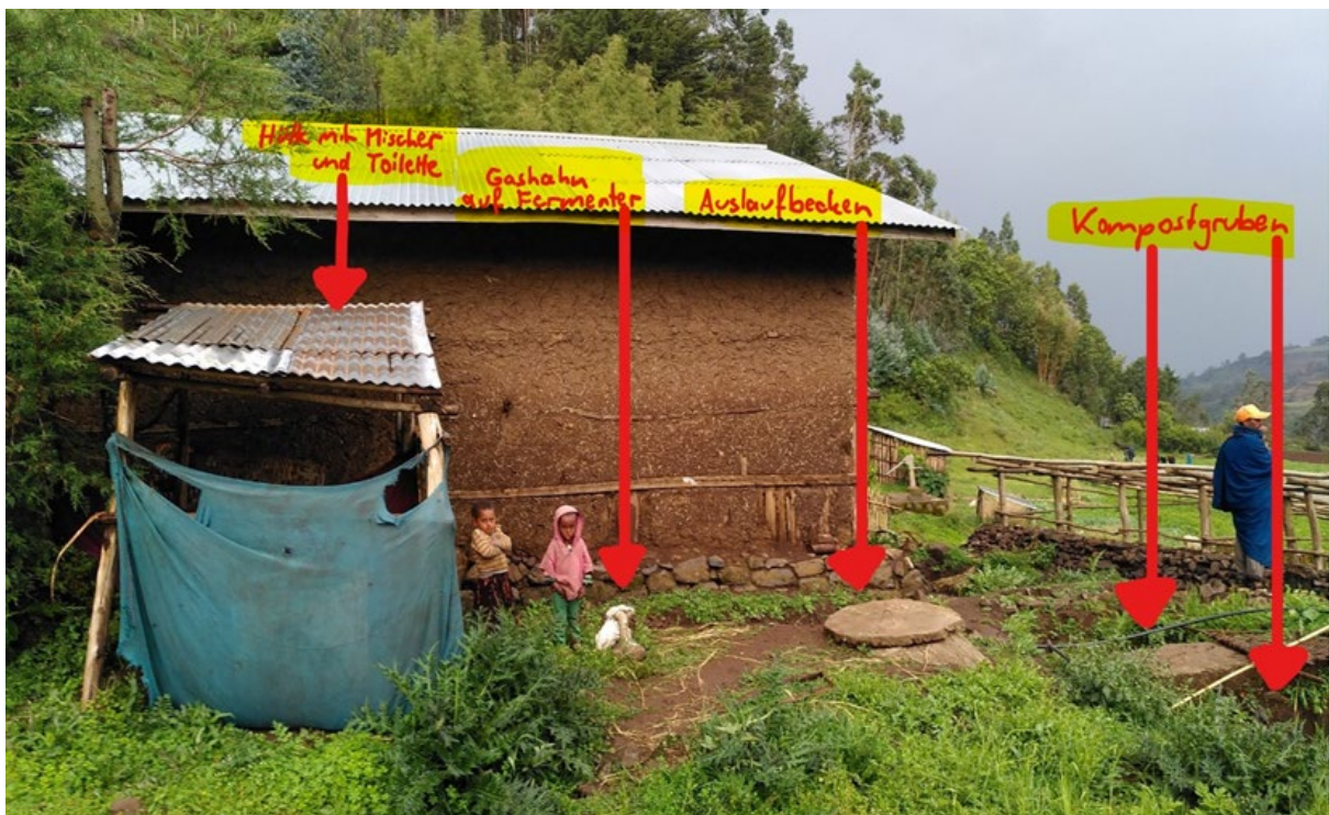
Abbildung 17 unterirdische Fixed Dome Biogasanlage auf Metadels Hof (Quelle: Eigenes Foto)
